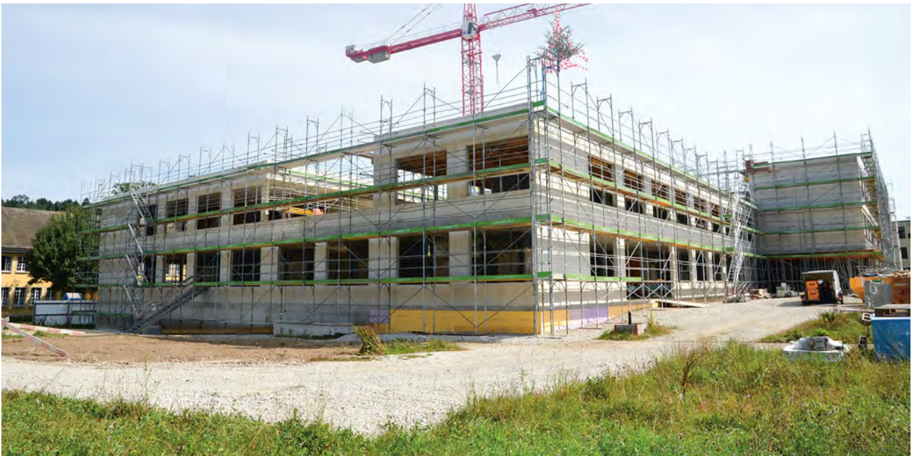
Aufrichte Neubau Haus C.
