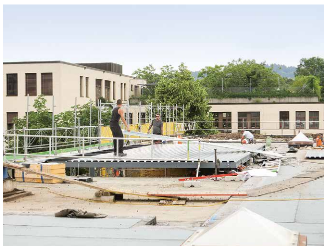
Gebäudehülle und Dachsanierung am Haus W
