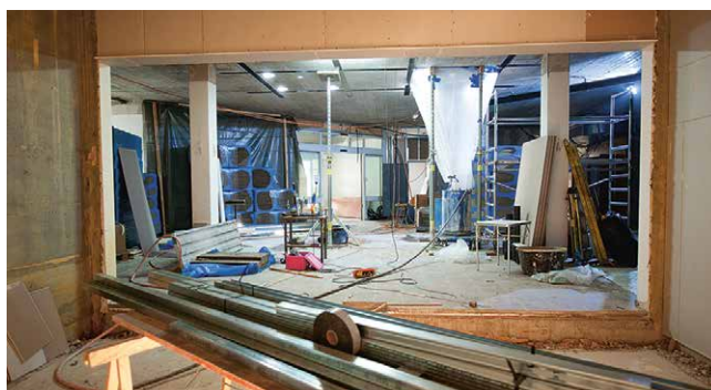
Die Umbauarbeiten schreiten zügig voran.
