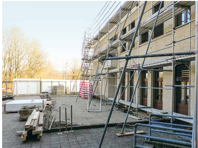
Januar 2020 – Anfang Januar wurden die Bauabschränkungen und das Gerüst montiert
