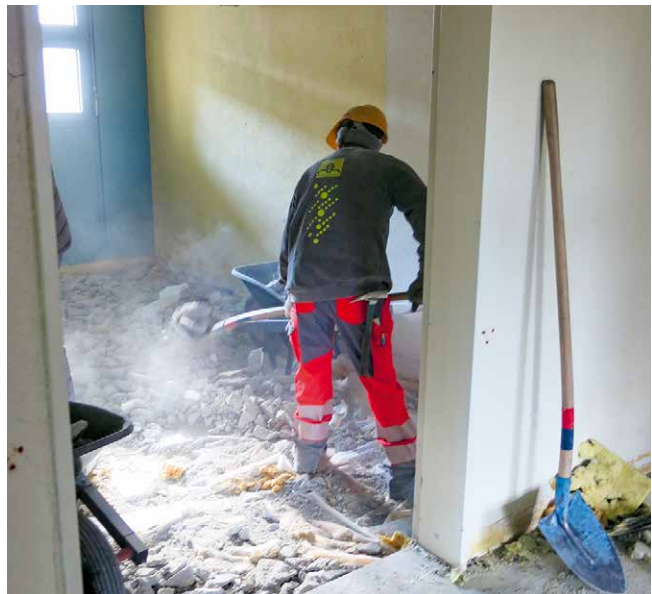
Februar 2020 – Rückbau auf die tragenden Strukturen
