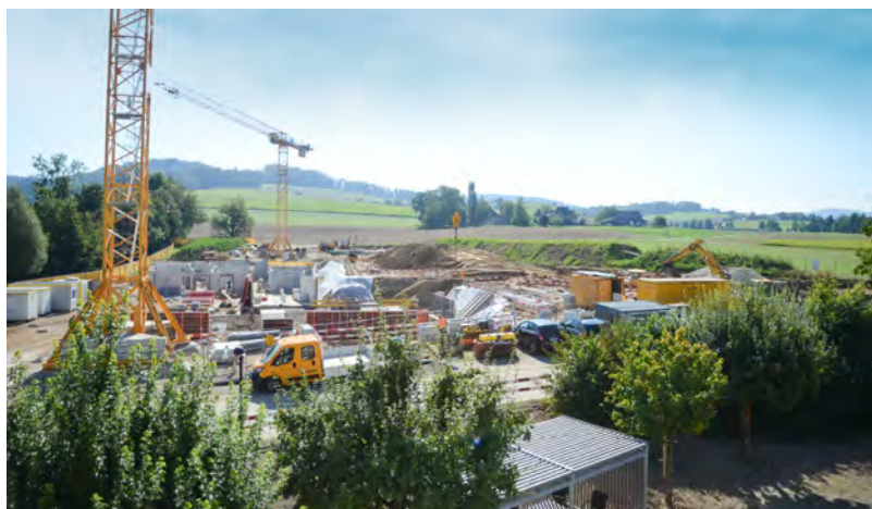
06. September 2021 – Baustelle Neubau Wohnheim Sonnegarte. Die Bauarbeiten schreiten planmässig voran. Die Aushubarbeiten erfolgten trotz regenreichem Sommer termingerecht. Mittlerweile ist das Fundament betoniert und erste Wände werden aufgezogen.
