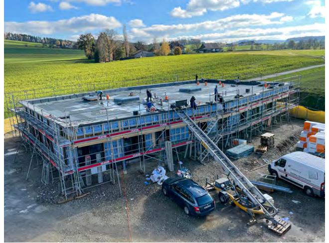
Baustelle Wohnheim Sonnegarte
