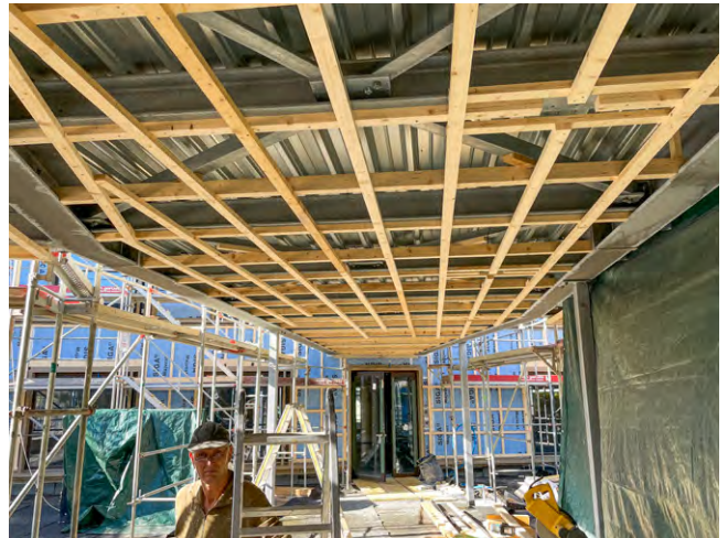
Der Innenausbau läuft auf Hochtouren
