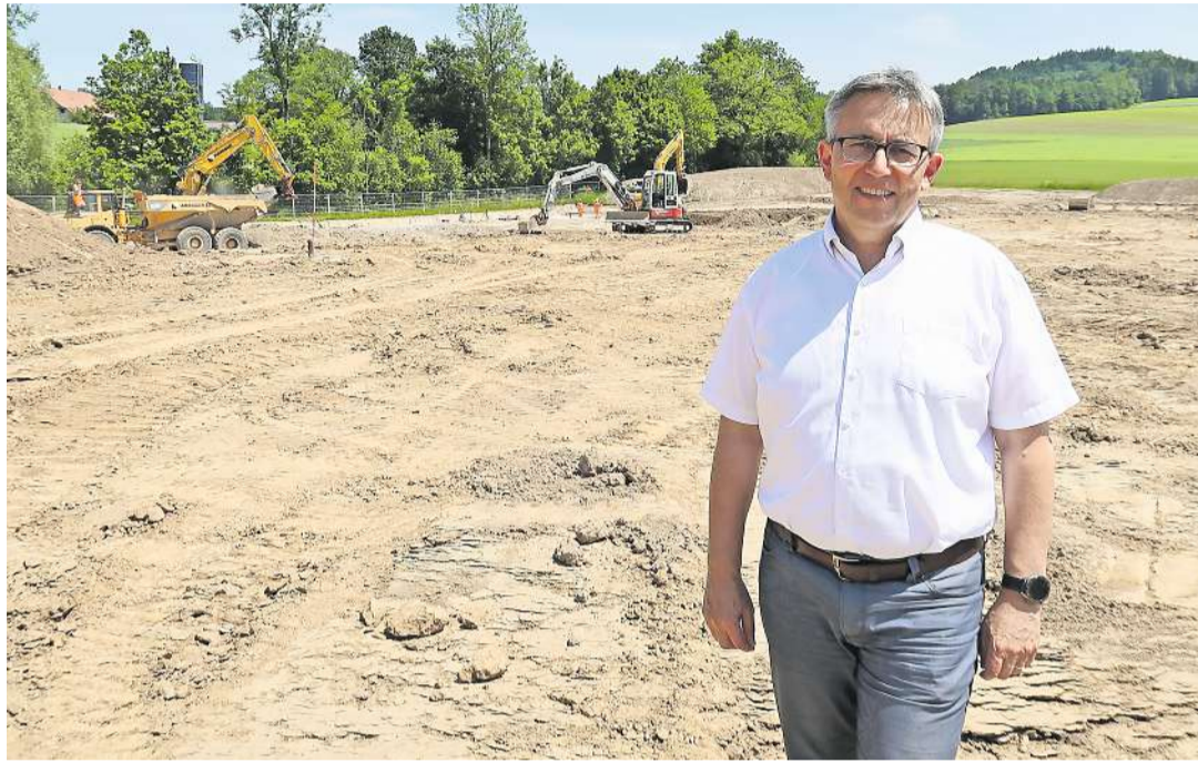
«Nun kann mit dem Aushub begonnen werden», sagt Thomas Lemp, stellvertretender Direktor der Luzerner Psychiatrie (Lups). Im Hintergrund ist die Baustelle zu sehen. Bild: rzu
