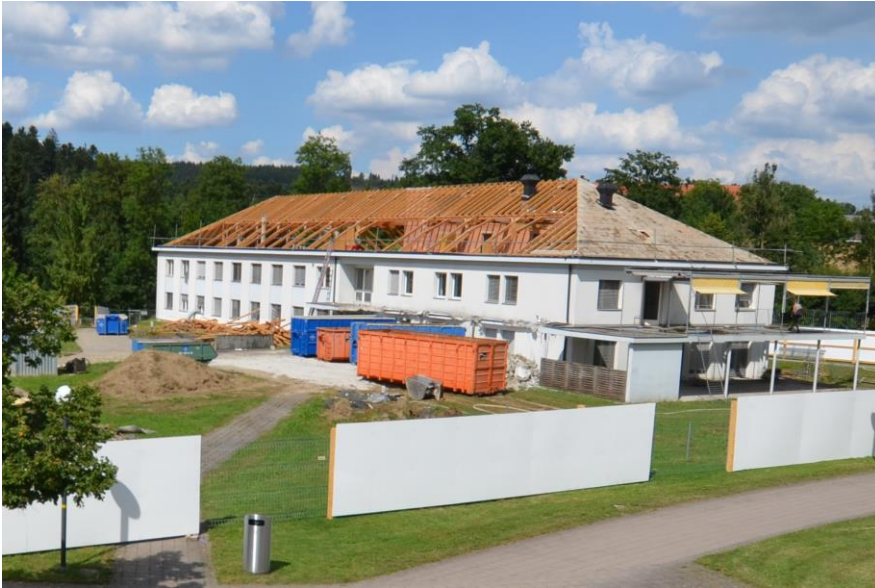
Rückbau Dach
