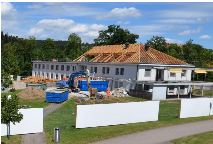
Rückbau Dach
